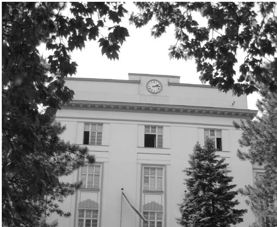
Zgrada Arhiva Jugoslavije
