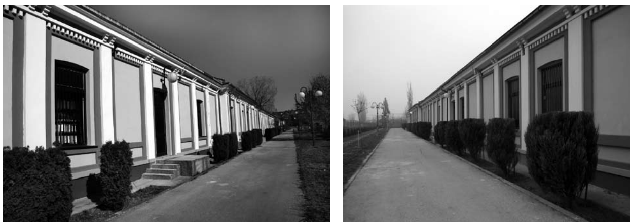
6. i 7. Zgrada arhivskog depoa „Stara kasarna 4“ posle završene rekonstrukcije i adaptacije, 2011. godine 6th and 7. Building archival depository “Old Barracks 4” after completion of reconstruction and renovation, 2011
