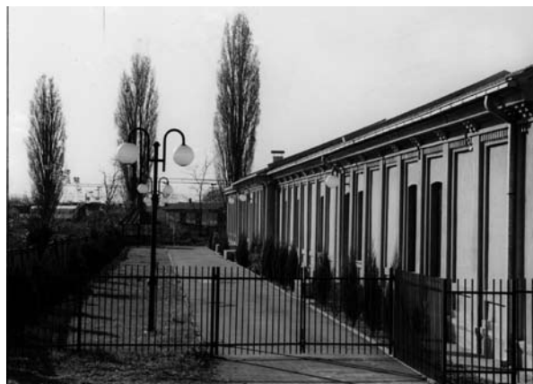
2. Objekat posle prve faze rekonstrukcije 1998.godine 2. Facility after the first phase of the reconstruction 1998
