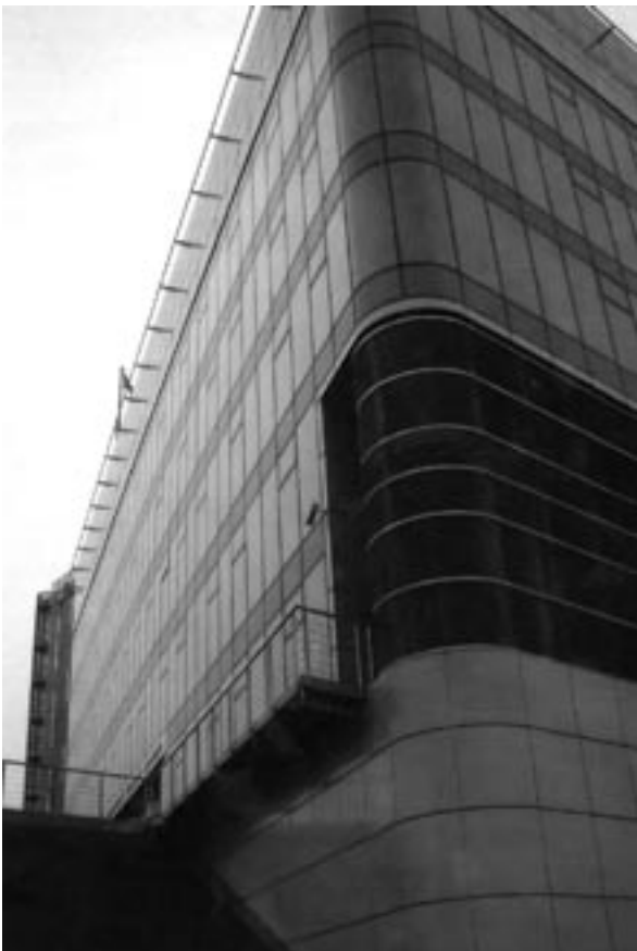
Slika 6: moderne arhivske stavbe
