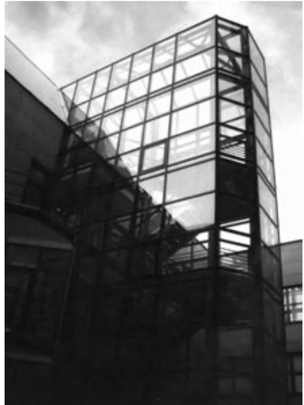
Slika 5: moderne arhivske stavbe
